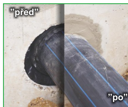
prostupy: malta SBM + bentonit
