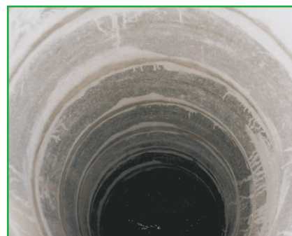
spárování šachtových skruží nebo trubních spojů
