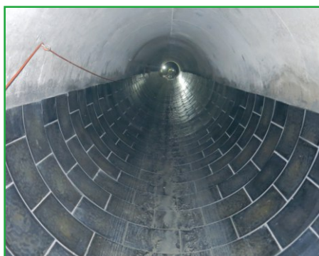
pokládka čedičových tvarovek
