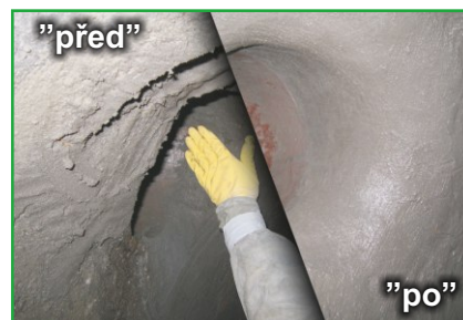
zapravení zaústění přípojek
