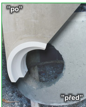
osazení šachtových vložek
